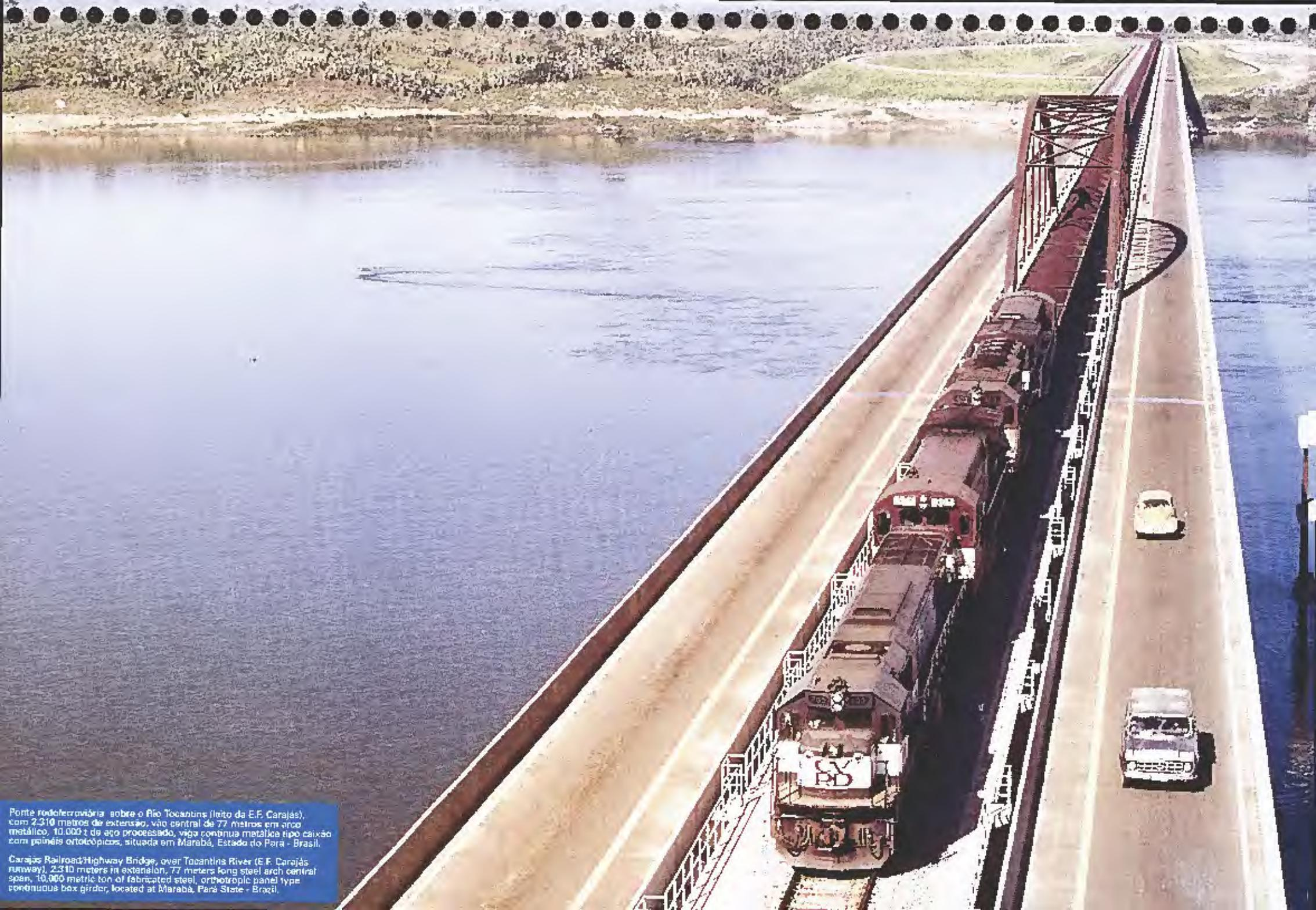
Ponte rodoferroviária sobre o Rio Tocantins (leito da E.F. Carajás), com 2.310 metros de extensão, vão central de 77 metros em arco metálico, 10.000 t de aço processado, viga contínua metálica tipo caixa com painéis ortotrópicos, situada em Marabá, Estado do Pará - Brasil.
