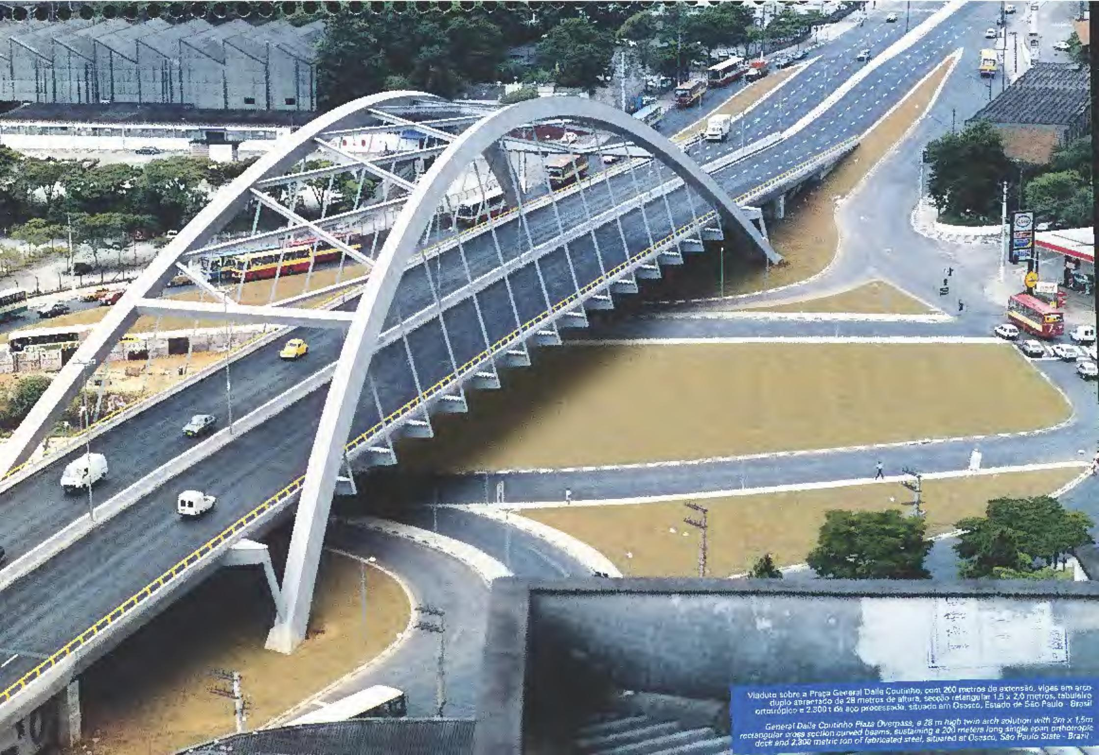
Viaduto sobre a Praça General Delle Cautinho, com 200 metros de extensão, vigas em arco duplo atarracado de 28 metros de altura, seção retangular 1,5 x 2,0 metros, tabuleiro ortotrópico e 2.300 t de aço processado, situada em Osasco, Estado de São Paulo - Brasil
