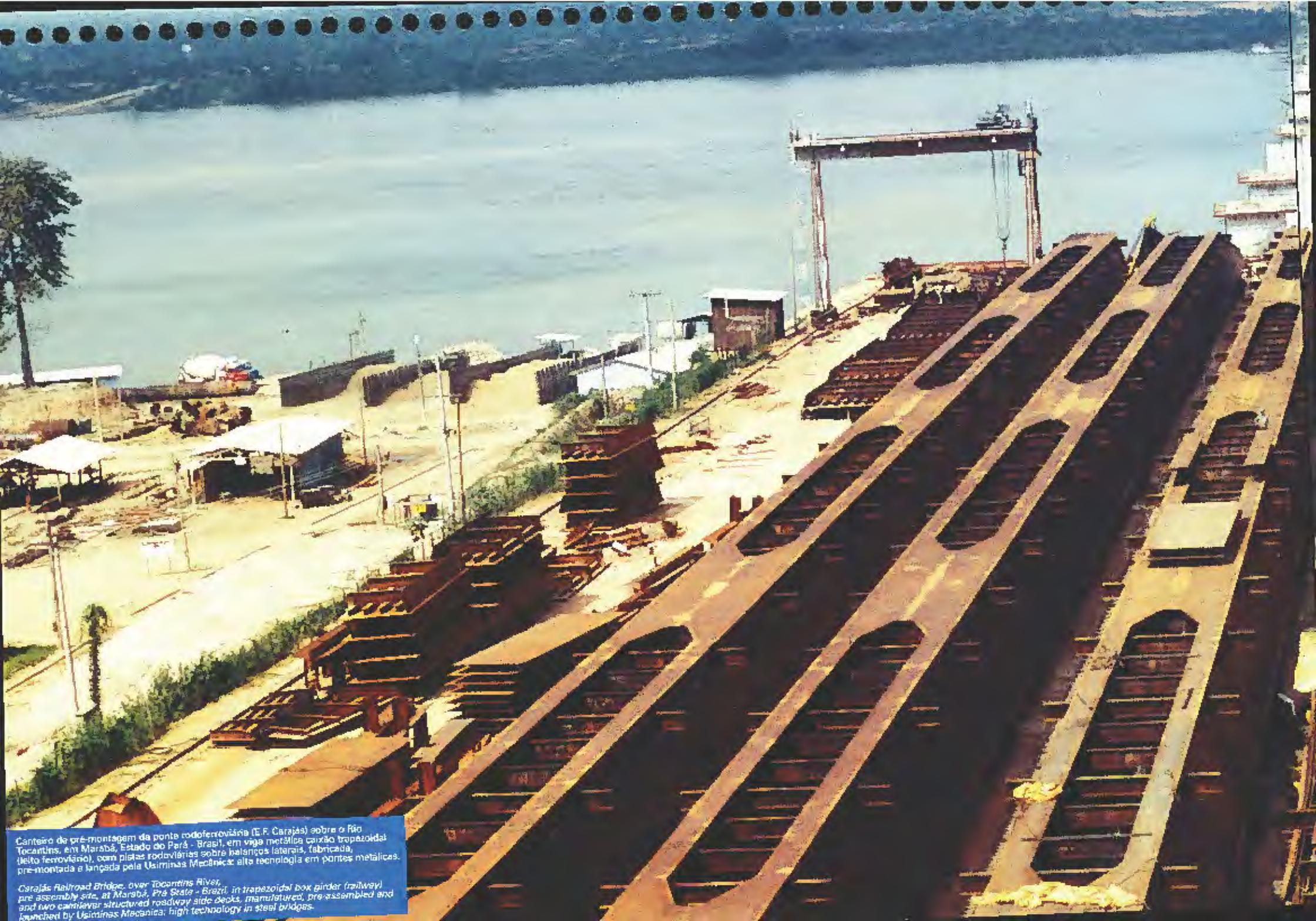
Canteiro de pré-montagem da ponte rodoferrviária (E.F. Carajás) sobre o Rio Tocantins, em Marabá, Estado do Pará - Brasil, em viga metálica caixa trapezoidal (tubo ferroviário), com pilares rodoviários sobre balanços laterais, fabricada, pré-montada e lançada pela Usiminas Mecânica: alta tecnologia em pontes metálicas.
