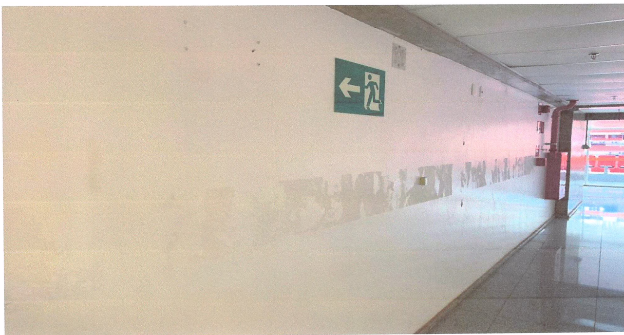
Imagem 20 – Marcas na pintura das paredes
