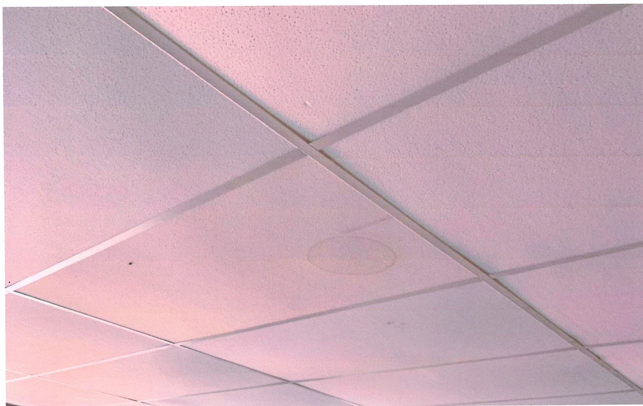
Imagem 12 – Infiltração no Forro
