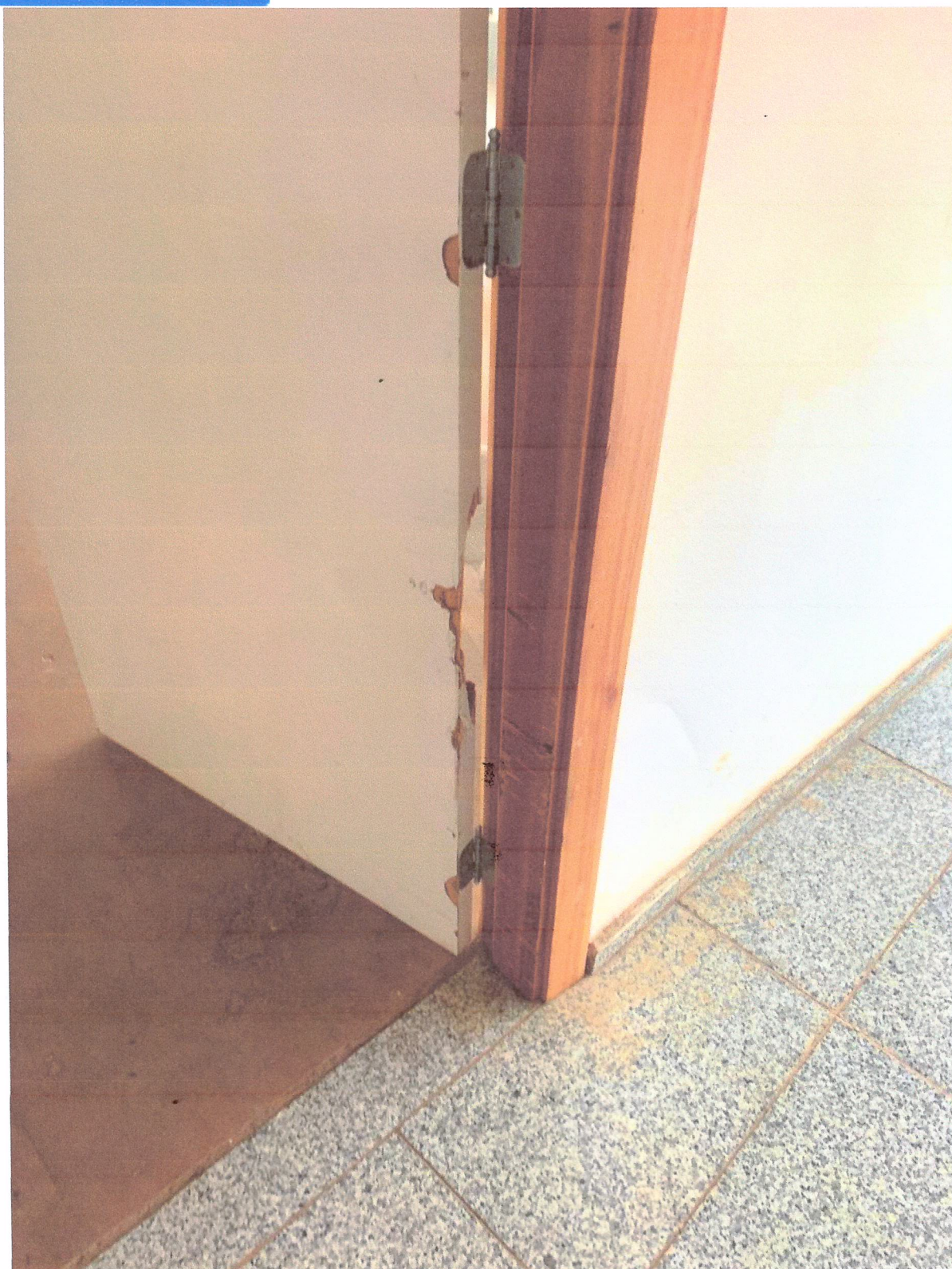
Imagem 30 – Portas de madeira danificadas
