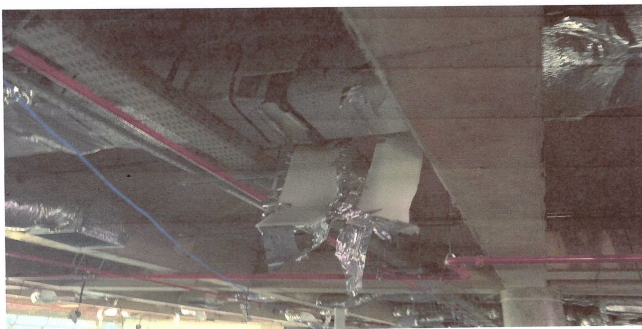
Imagem 33 – Falta de Isolamento Térmico
