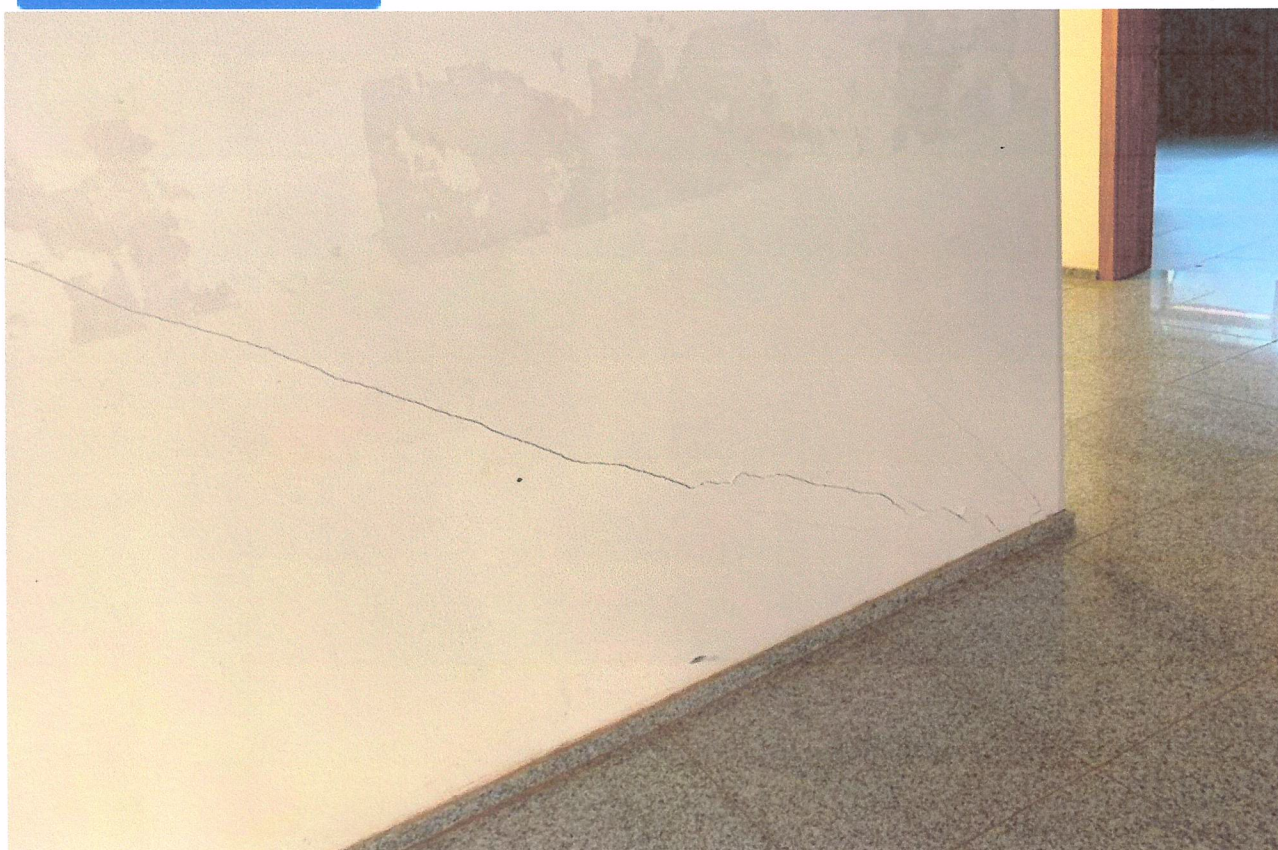
Imagem 8 – Fissura em Paredes
