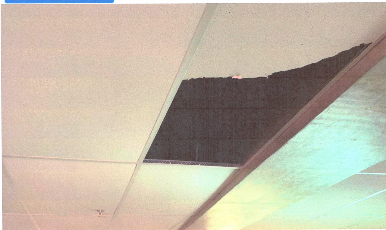
Imagem 16 – Placas de forro quebradas
