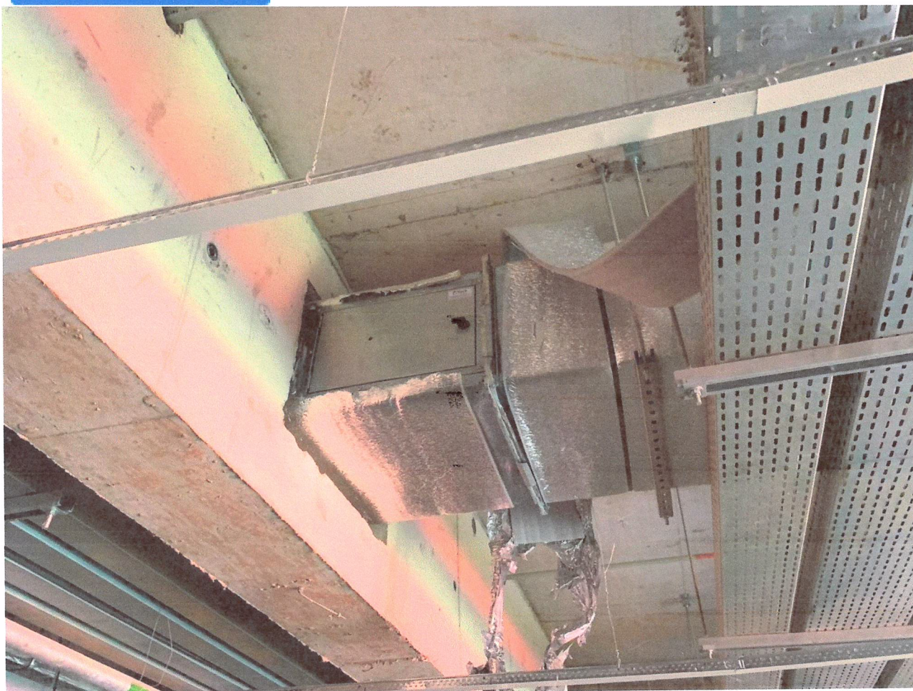
Imagem 32 – Falta de Isolamento Térmico
