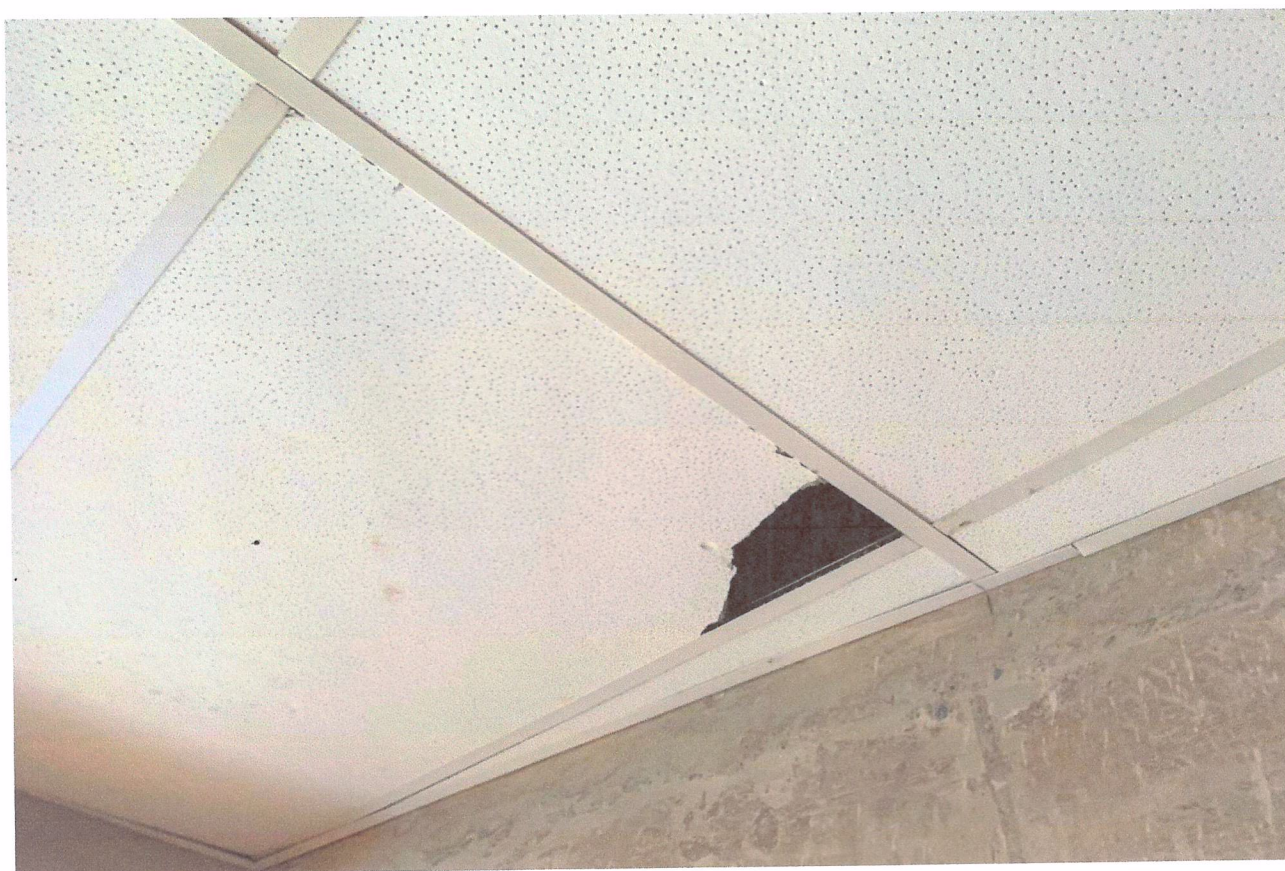
Imagem 17 – Placas de forro quebradas
