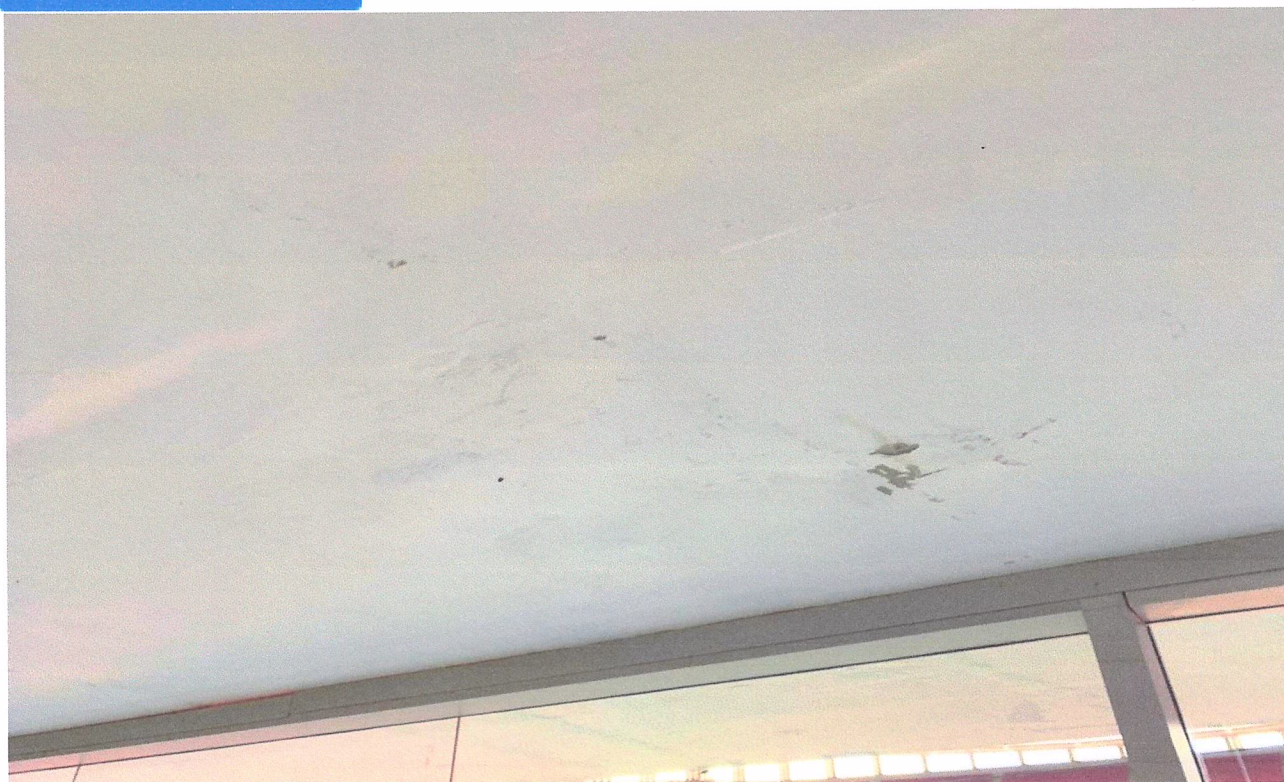
Imagem 25 – Danos na pintura dos tetos
