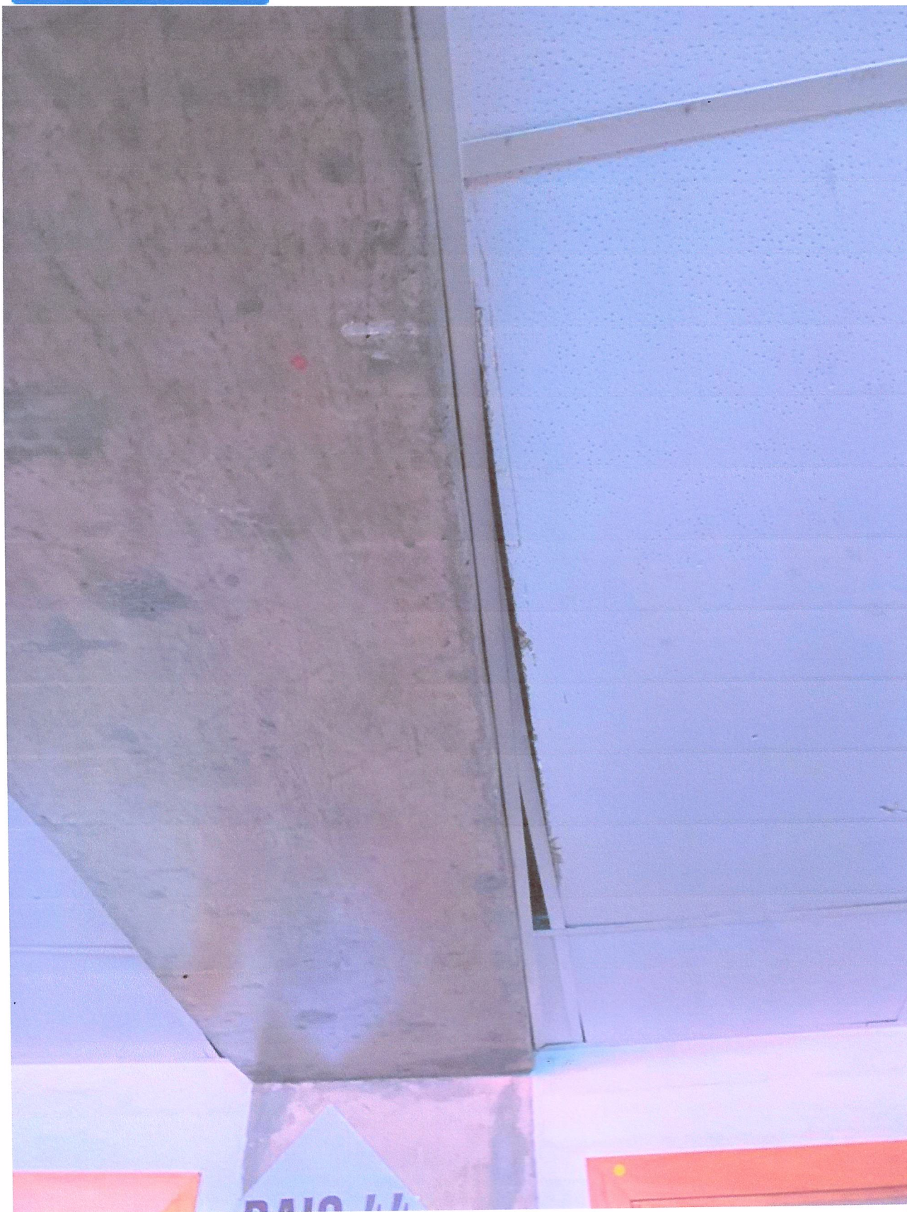
Imagem 19 – Montantes do forro danificados
