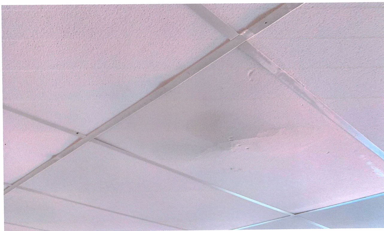
Imagem 19 – Infiltração no Forro
