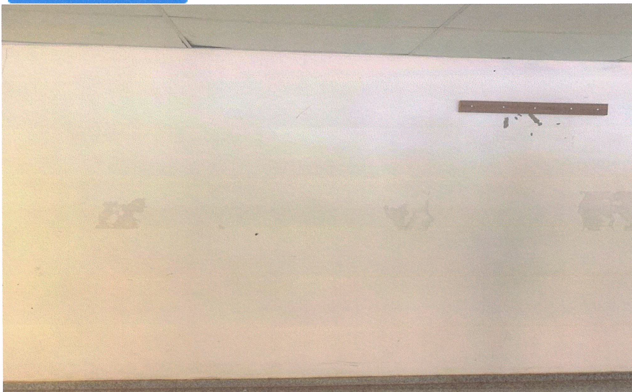
Imagem 23 – Sujeira e danos na pintura das paredes
