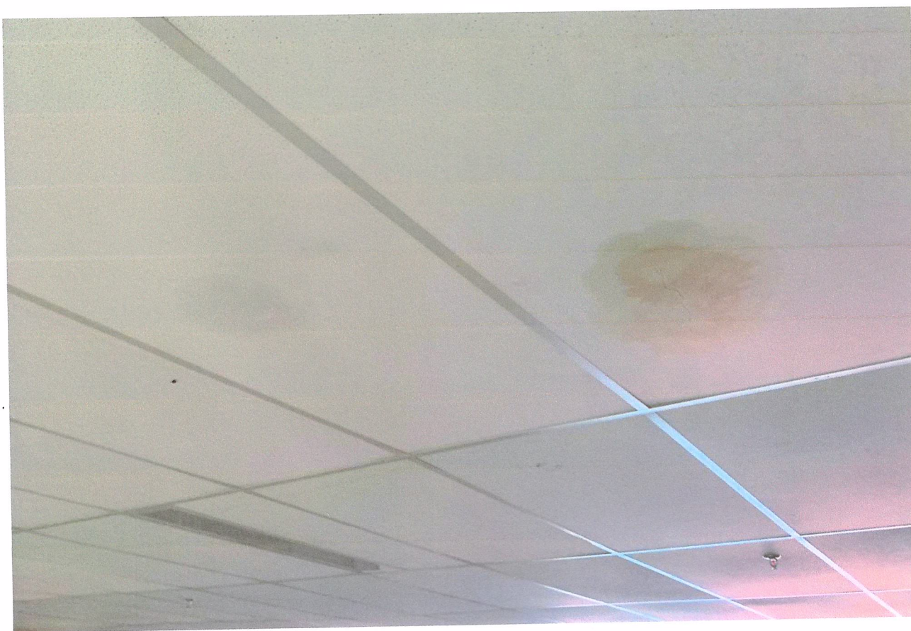
Imagem 14 – Infiltração no Forro
