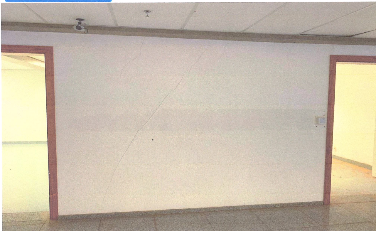
Imagem 2 – Fissura em Paredes
