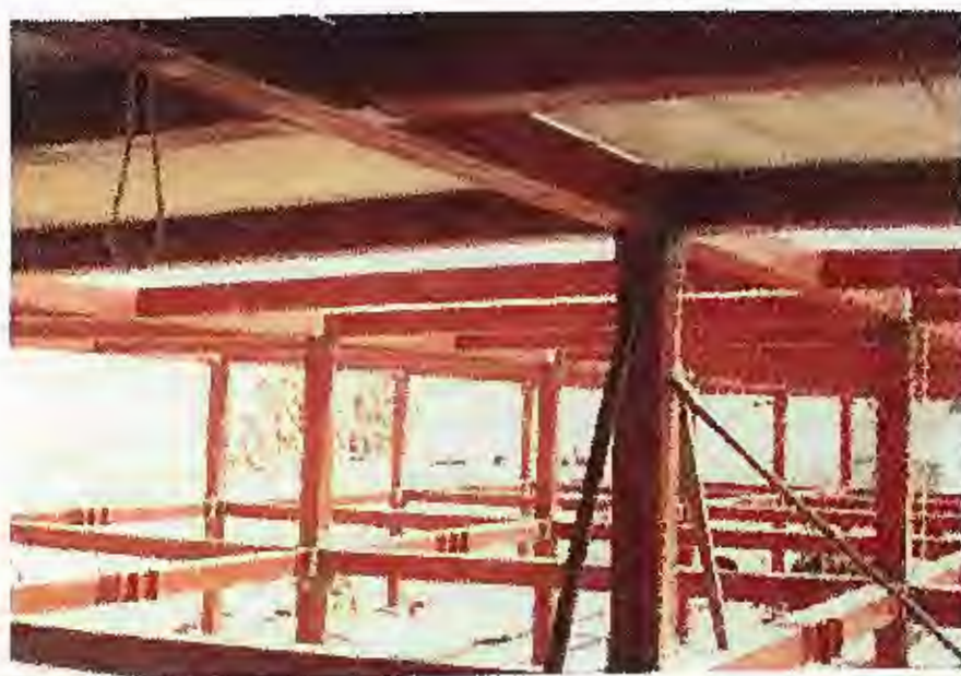
Figura 11 - Lajes REAGO e estrutura metálica de perfis formados a frio
