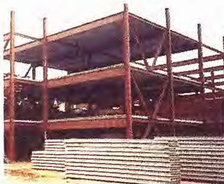
Figura 10. Lajes REAGO, em estruturas metálicas [4].
