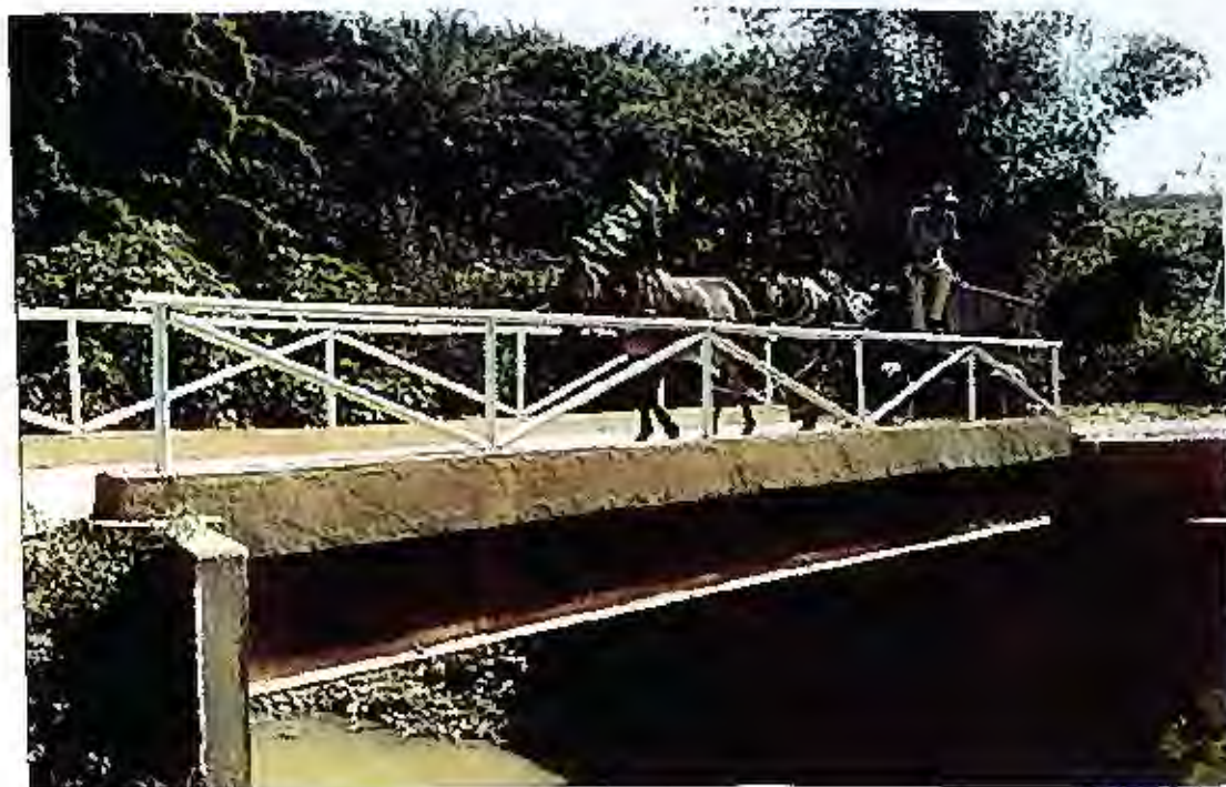
Aplicação em ponte vicinal
