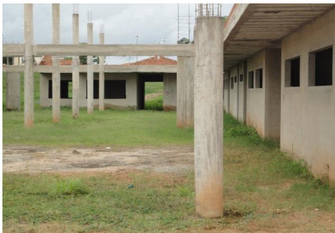
Obra ID 24843 em metodologia tradicional. Jaraguá/GO. Obra parcialmente executada e paralisada. Março/2015
