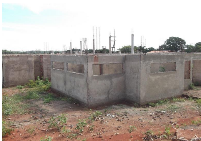
Obra em Coelho Neto/MA. Execução parcial das estruturas e posterior paralisação. Março/2014
