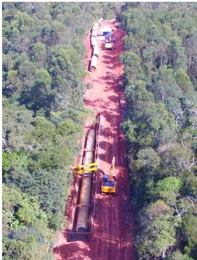
adutora de água bruta \phi 2.100 \text{ mm} , L = 49,3 \text{ km}
