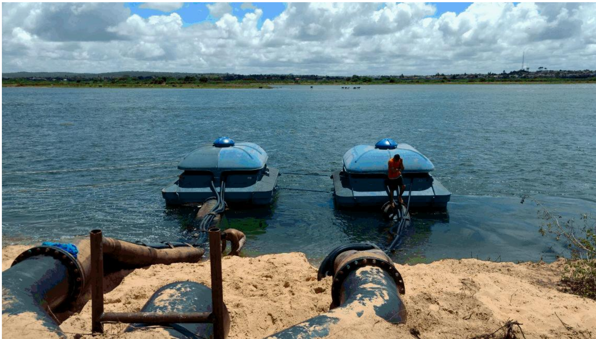
Tomada de água no rio São Francisco para abastecimento de Aracajú com bombas flutuantes cedidas pela Sabesp (outubro de 2017)
