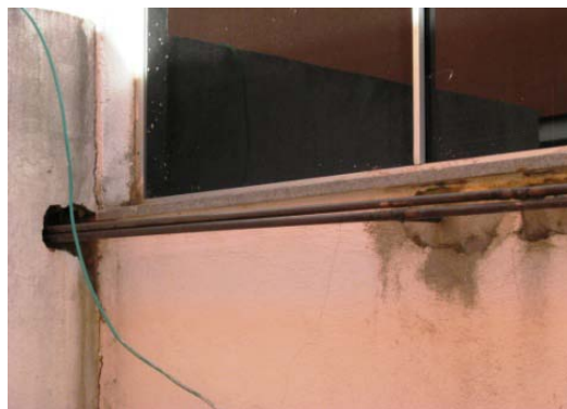
Tubulações executadas depois das obras prontas – Formosa/GO
