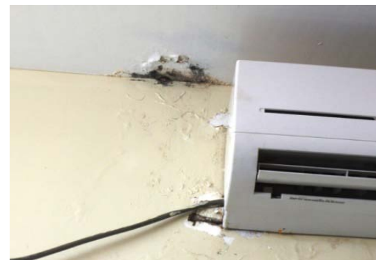
Infiltrações – Belém/PA
