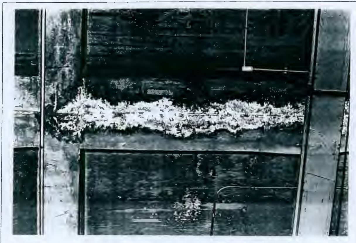
Fig. 5 e 6: Carbonatação em juntas de viga com viga e viga com laje no teto do subsolo I bloco III
