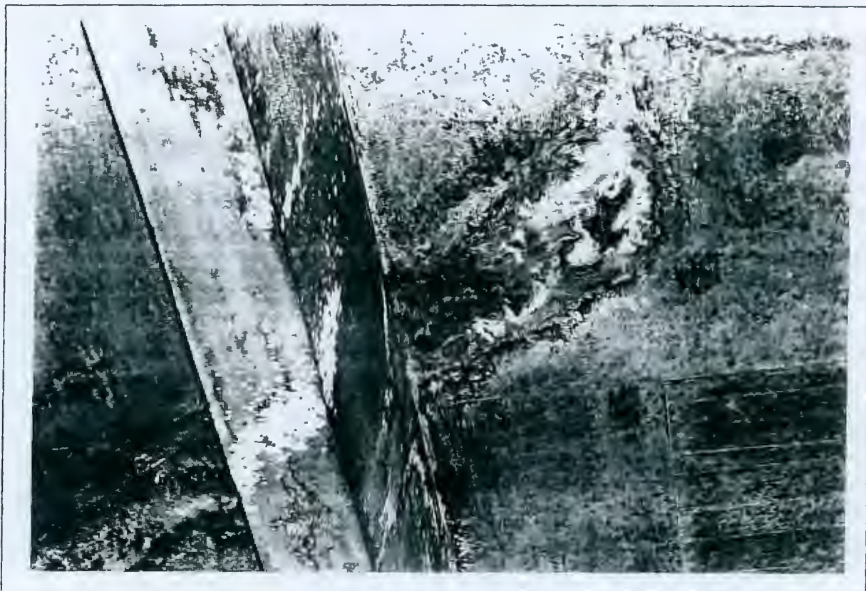
Fig. 9 e 10: Carbonatação na laje e juntas de vigas do teto do subsolo I bloco III devido a infiltrações pelas falhas na camada asfáltica e manta impermeabilizante do pavimento térreo
