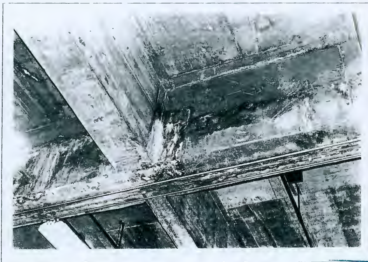
Fig. 9 e 10: Carbonatação na laje e juntas de vigas do teto do subsolo I bloco III devido a infiltrações pelas falhas na camada asfáltica e manta impermeabilizante do pavimento térreo
