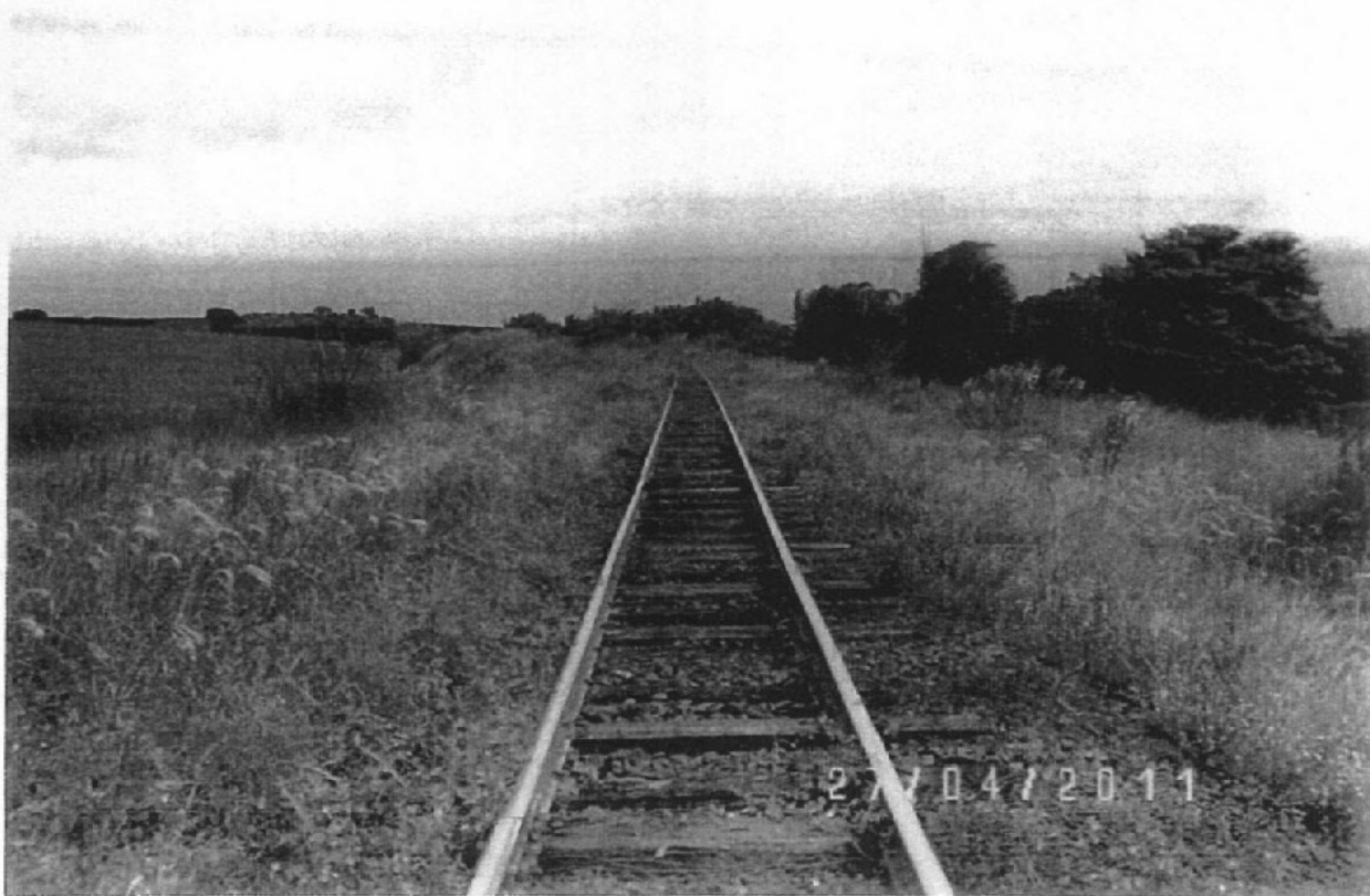
Foto 35: Trecho operacional da ferrovia encoberto pela vegetação (ALL – Malha Oeste).
