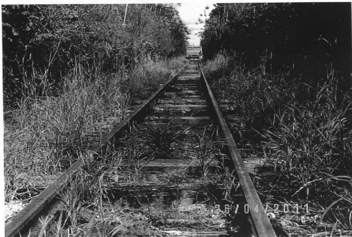
Foto 13: trecho operacional coberto pela vegetação – manutenção deficiente (ALL Malha Oeste).
