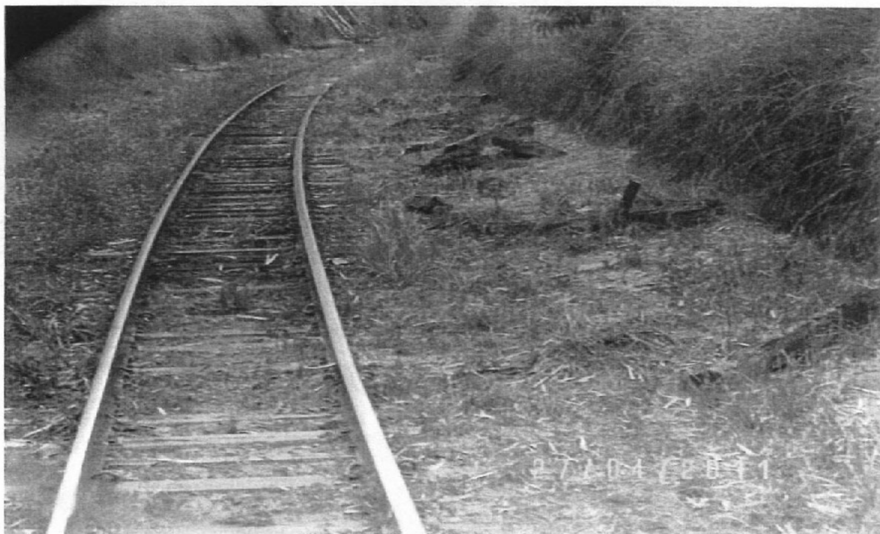
Foto 31: contaminação do lastro por deficiência de drenagem e capina deficiente em trecho operacional (ALL Malha Oeste).
