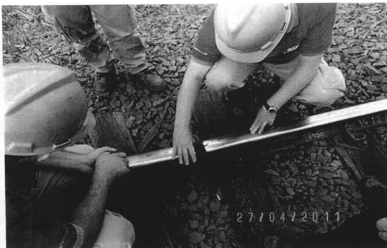
Foto 24: espaçamento acentuado entre trilhos em ponto do trecho visto na foto 23 (ALL Malha Oeste).
