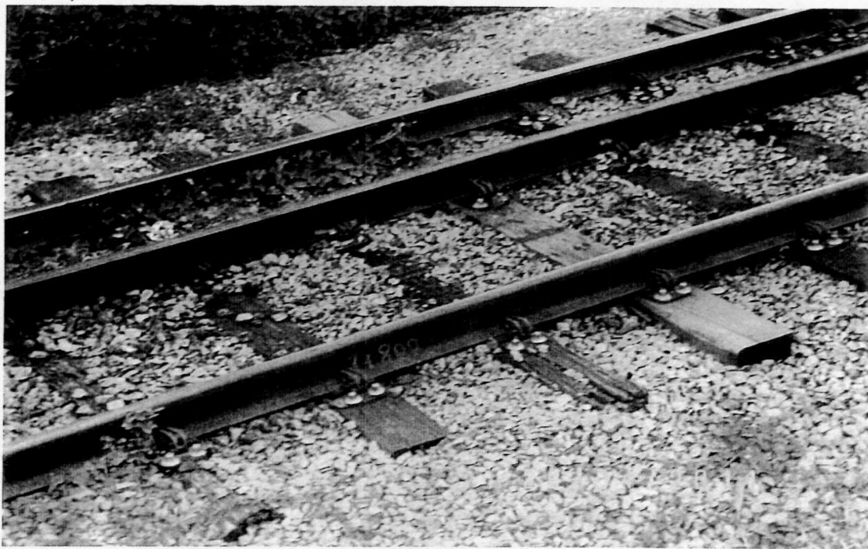
Foto 51: trecho em bitola larga com terceiro trilho adaptado. Fixação elástica, dormentes de madeira.
