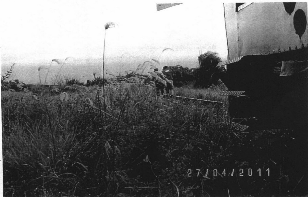
Foto 32: trecho operacional recoberta por vegetação – capina deficiente (ALL Malha Oeste).
