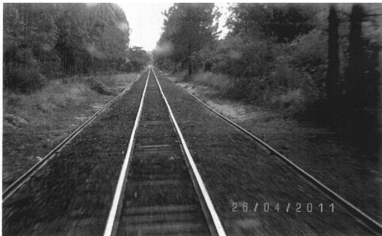
Foto 22: imagem obtida em trecho percorrido pelo auto de linha. Observar as valetas laterais de drenagem (ALL Malha Oeste).
