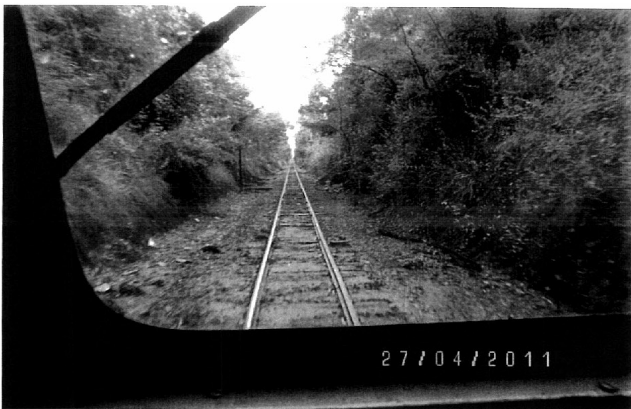
Foto 26: contaminação do lastro por deficiência de drenagem em trecho operacional (ALL Malha Oeste).
