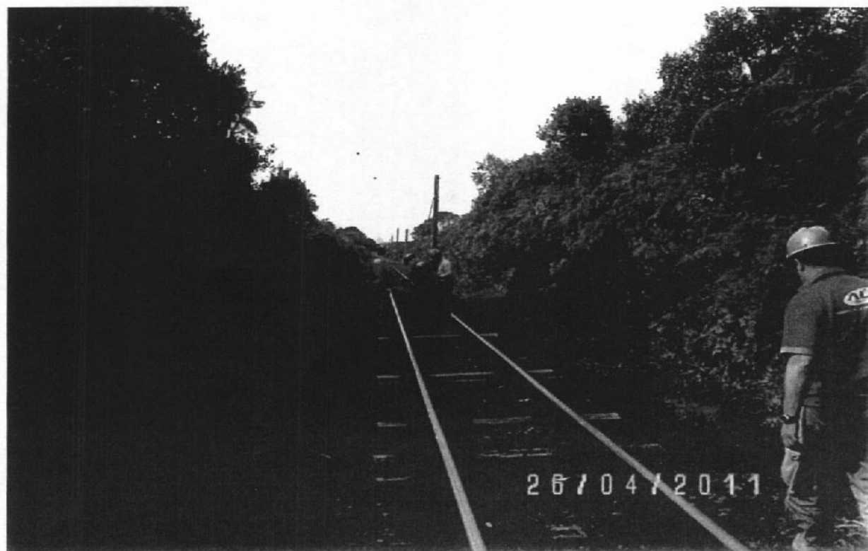
Foto 7: Contagem de dormentes em trecho ferroviário (ALL – Malha Oeste).
