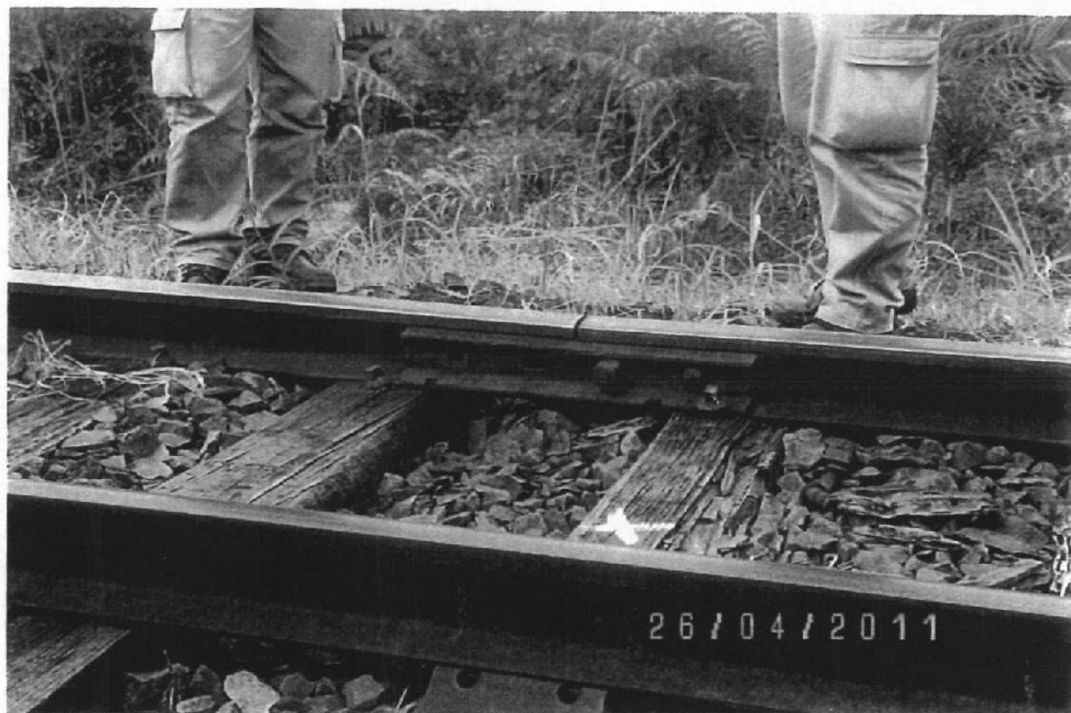
Foto 14: outra junta desligada (ALL Malha Oeste).
