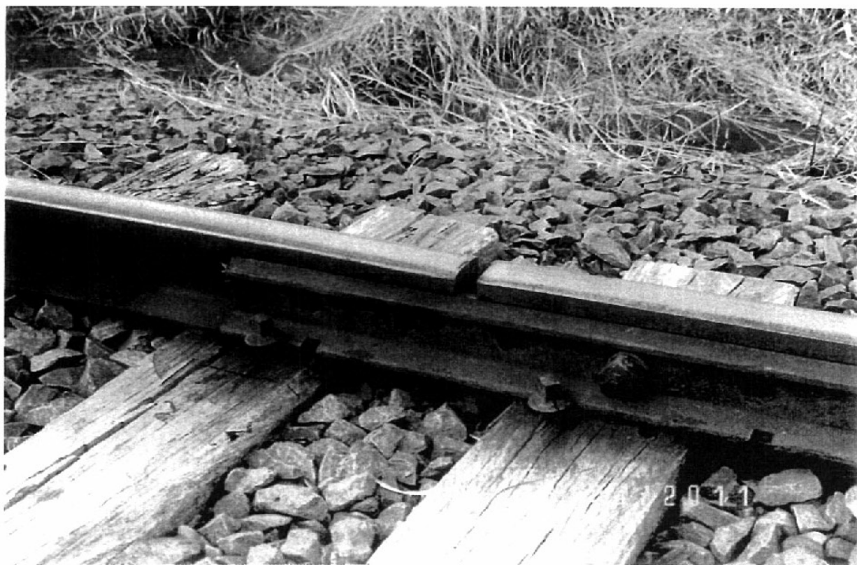
Foto 11: junta desligada. Observar o espaçamento entre os trilhos (ALL Malha Oeste).
