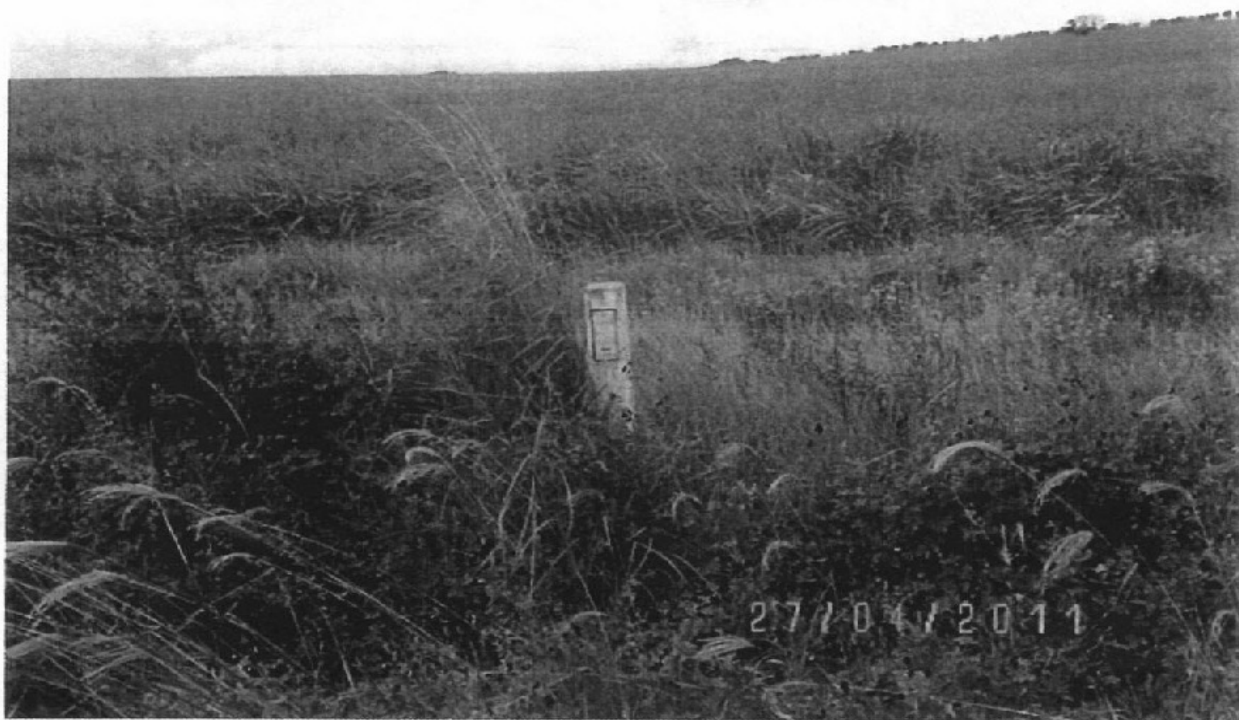
Foto 34: Marco de cabo de fibra ótica encoberto pela vegetação (ALL – Malha Oeste).
