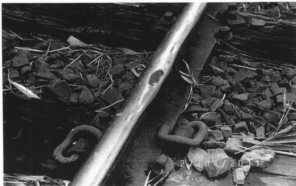
Foto 29: sinais de "patinação" em trilho. Uso de tirefond e fixação elástica (ALL Malha Oeste).
