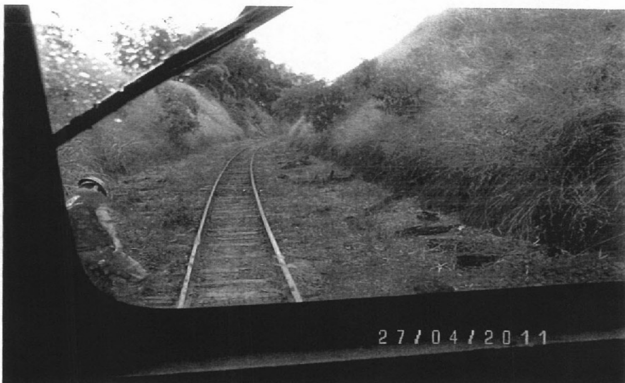
Foto 30: contaminação do lastro por deficiência de drenagem e capina deficiente em trecho operacional (ALL Malha Oeste).
