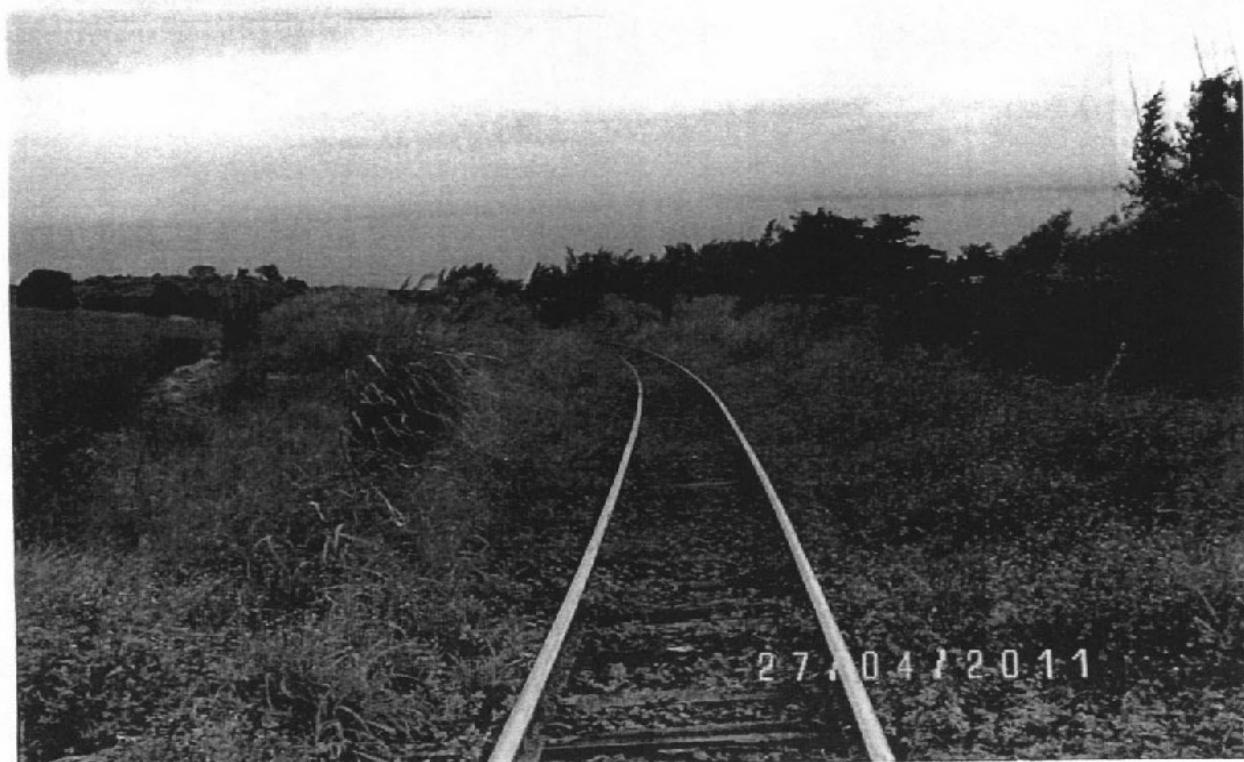
Foto 33: trecho operacional recoberta por vegetação – capina deficiente (ALL Malha Oeste).
