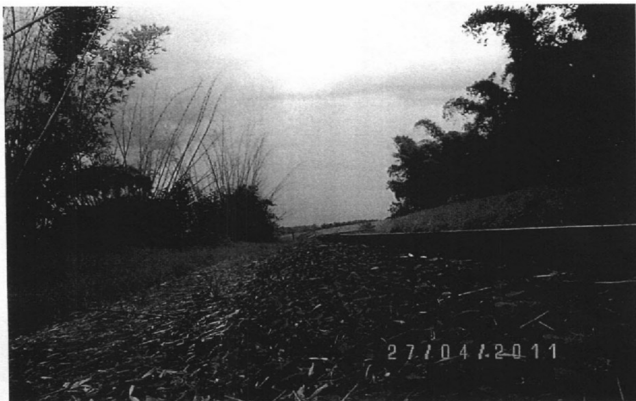
Foto 28: detalhe do lastro em brita (ALL Malha Oeste).
