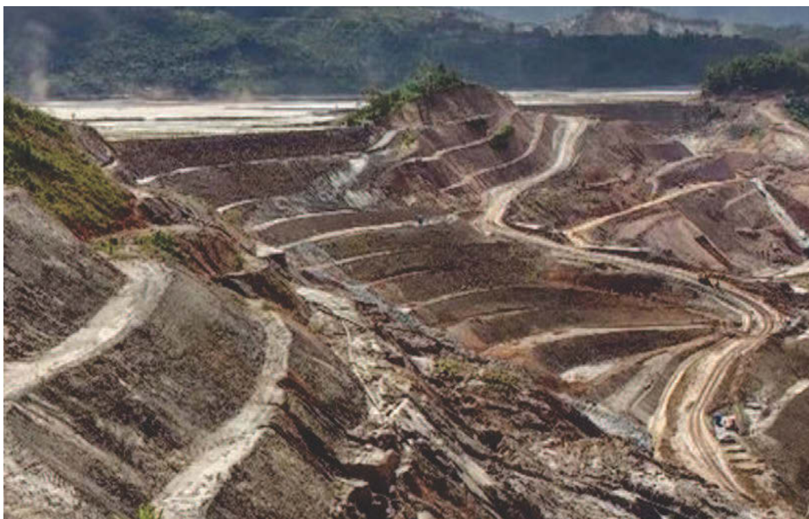
Figura 23 – Construção de bermas de equilíbrio na barragem de Germano
