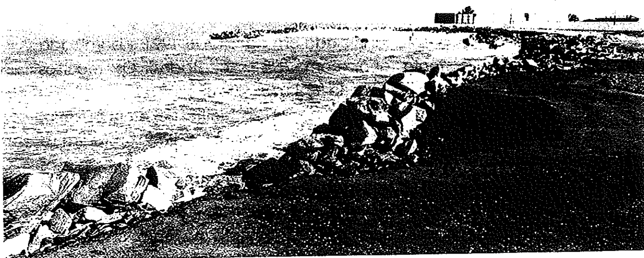
Obra de proteção da Praia da Coroa do Meio em Aracajú-SE
